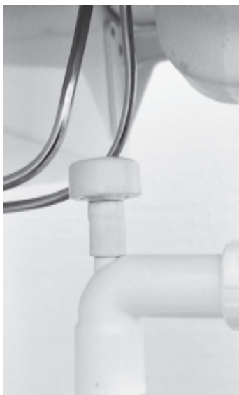
Lätt att montera vacuum- ventil med ny slanganslutning. (endast FLEXIPUNG).
