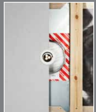
Steg 10. Montera taket och installera armaturerna.
