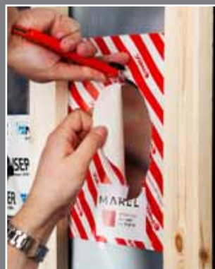
Steg 9. Skär hål i diffspärretejpen och vik in i säkerhetsboxen.
