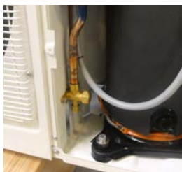
Bild 19: Serviceventil vätskeledning
