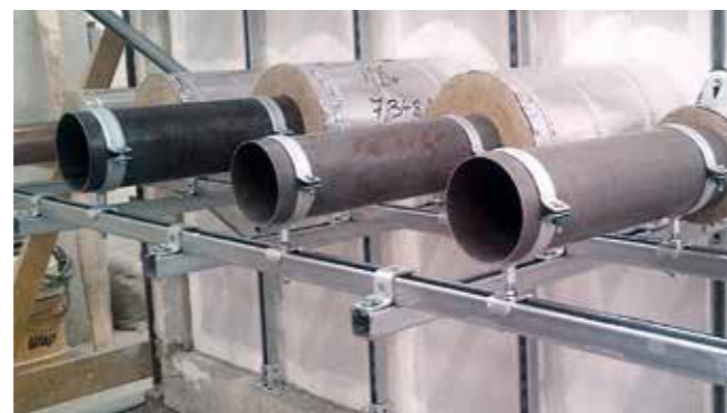
BRANDPROVNING AV ÖPPNA SYSTEM
