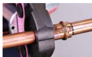
12. Tryck på beslaget med det godkända pressverktyget
