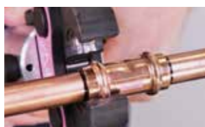
11. Styr monteringen i pressklon
